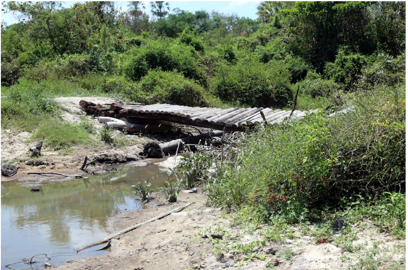
Abb. 2: Die Brücke erschien uns doch nicht geeignet, um mit unserem Auto darüber zu fahren.
